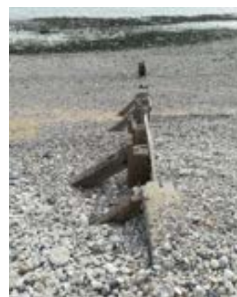
Figure 25 : Photos de l'épi n°8 (ARTELIA, 4/06/2020)
