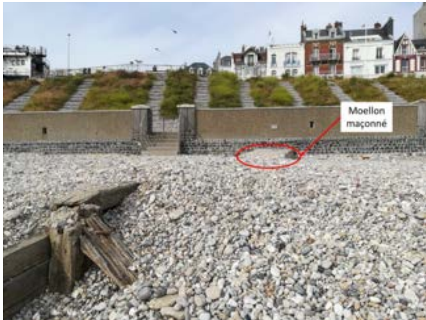
Figure 27 : Moellon maçonné à l'enracinement de l'épi existant - potentiel contrefort de digue
