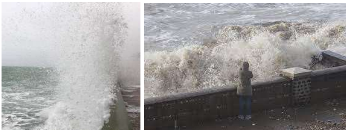
Perré au droit du casier entre l'épi 8 et l'épi 9 : franchissements plus réguliers
