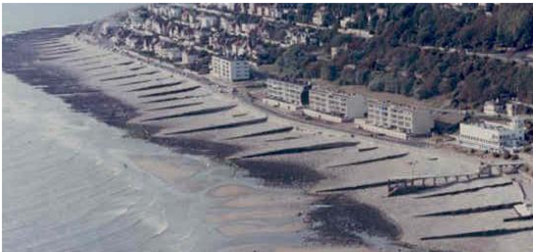
Vue aérienne d'une partie des ouvrages concernés (plage de Sainte-Adresse)
