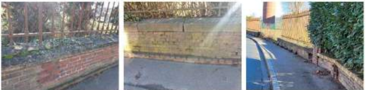
Photos du muret existant de l'ancienne enceinte
