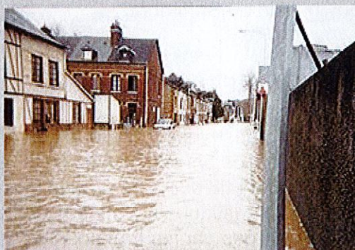
Inondations de 1999 à Pavilly
