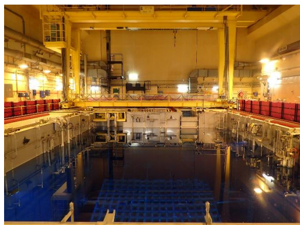
Piscine combustible usé (Com ion d'enquête)
