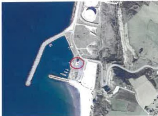
Figure 2 : Toit concerné sur la zone d'Antifer
