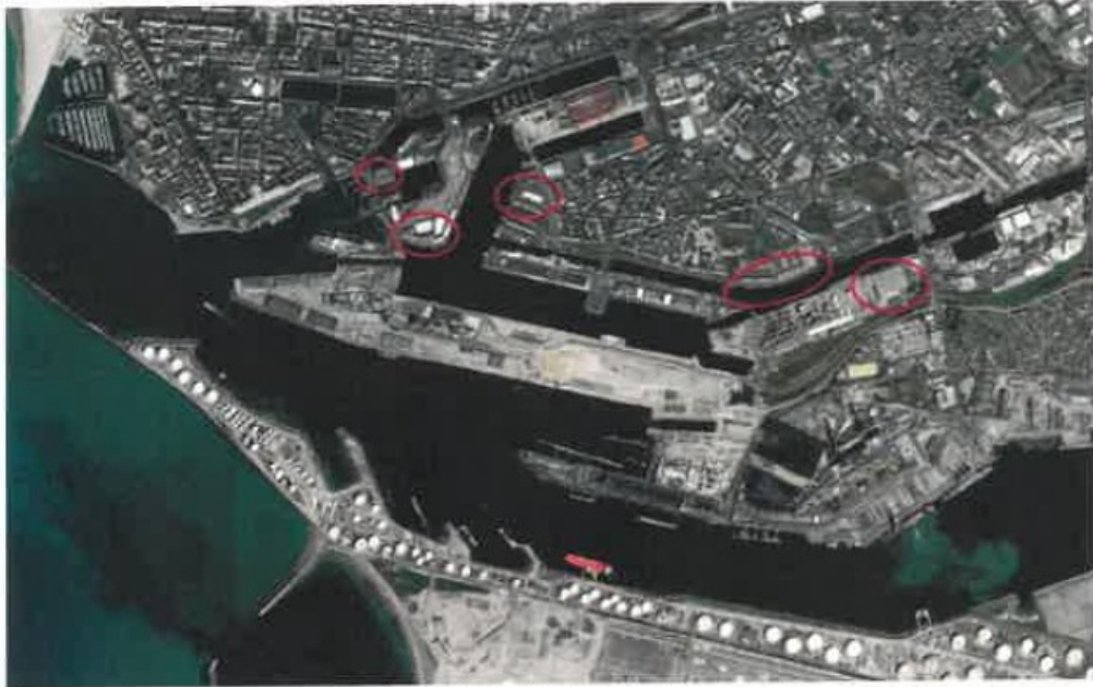
Figure 1 : Ensemble des toits de la zone portuaire concernés
