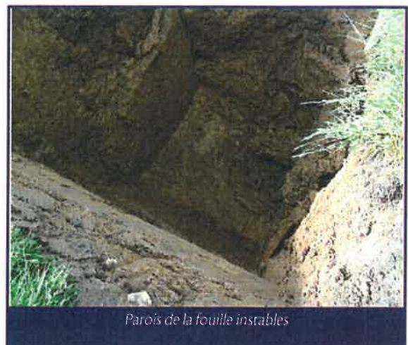
Photo 4 (vues a et b) : Approfondissement de la fouille
