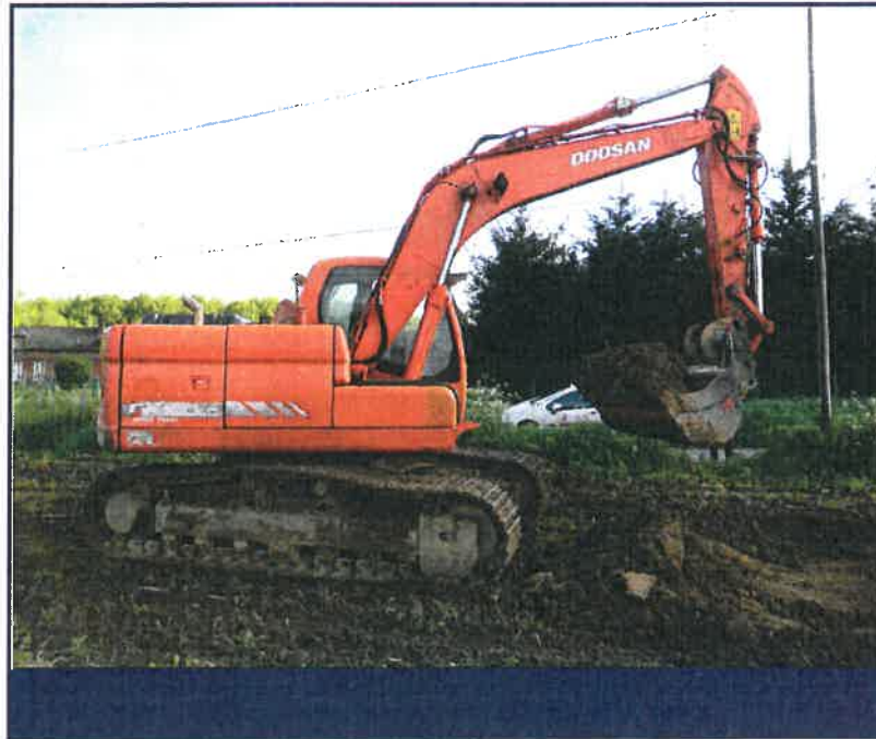
Photo 1 : Pelle mécanique 16 tonnes utilisée.
