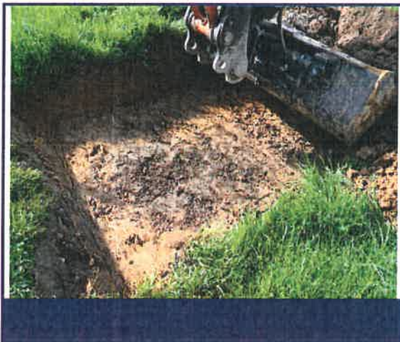
Photo 4 (vues a et b) : Approfondissement de la fouille
