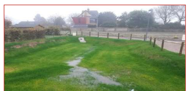
Première mise en eau de l'ouvrage
