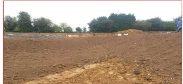
Recapage de la terre végétale
