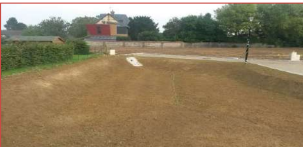
Finition des terrassements
