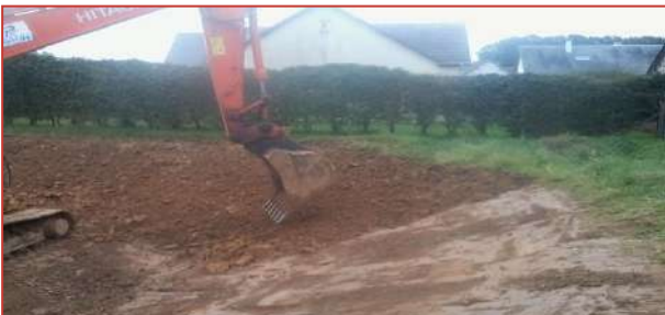
Décompactage et griffage
