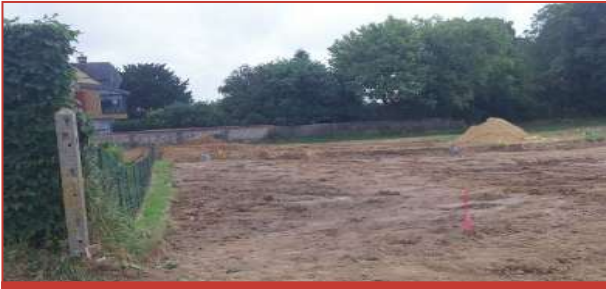
Décapage de la terre végétale
