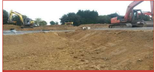
Réalisation des terrassements
