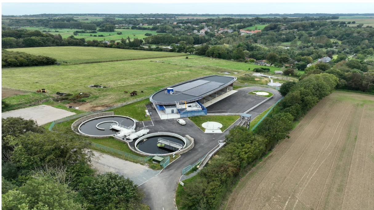
Station d'épuration de Longueil
