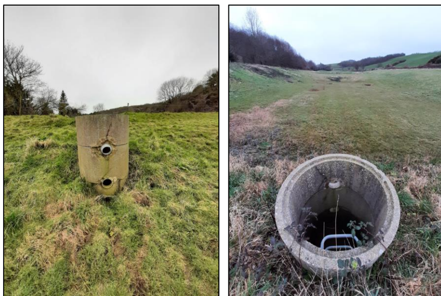
Figure 10 : Ouvrages de régulation actuels des barrages : exemple du barrage aval.
