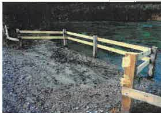
Abreuvoir aménagé par le SIRAS (Source : SIRAS)
