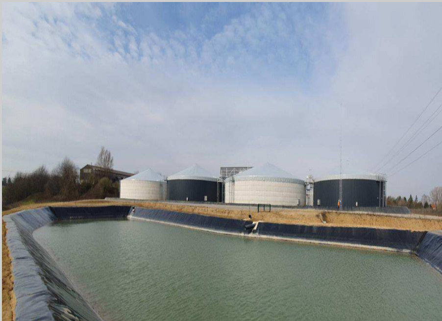
Unité de méthanisation (source : dossier BioNorrois - étude d'impact)
