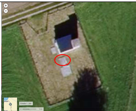
Ouvrage en béton situé entre le captage et le bâtiment technique à neutraliser (ancienne bêche probable)
