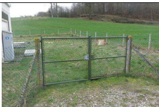
Portail et clôture de protection de 1.6 m de hauteur autour de la station de pompage à remplacer
