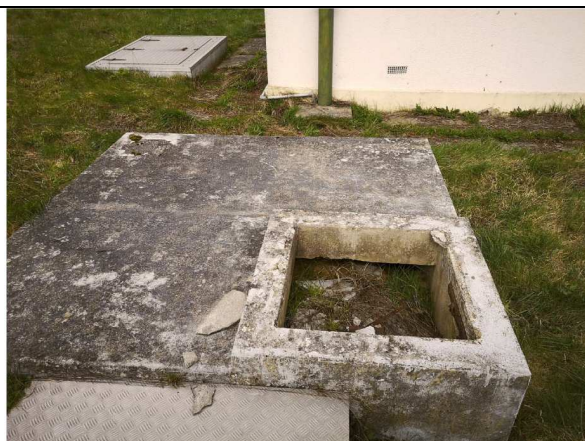
Ouvrage béton à neutraliser
