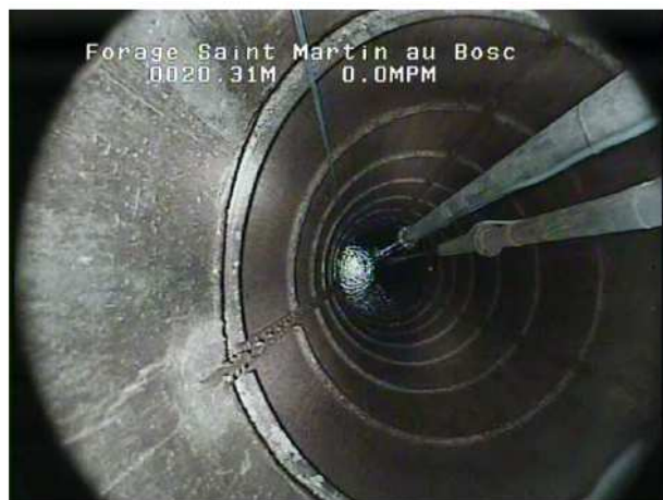
Partie inférieure du cuvelage en béton avec vue d'ensemble de la 2 nd e partie du puits en coffrage métallique
