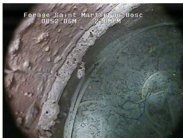
Partie basse du puits
