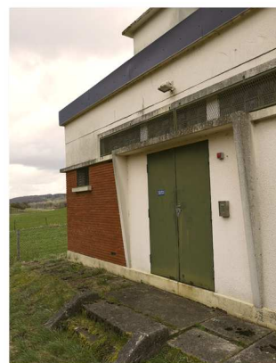
Vue sur la porte de la station de pompage
