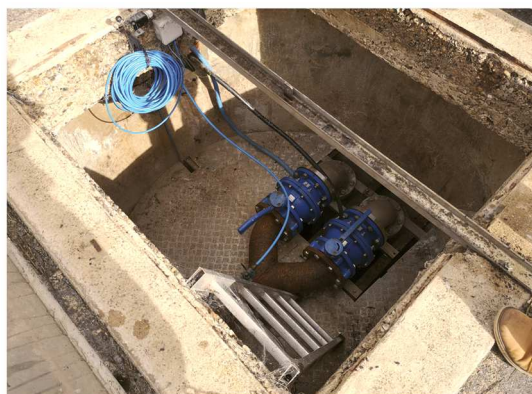
Vue sur l'accès au forage
