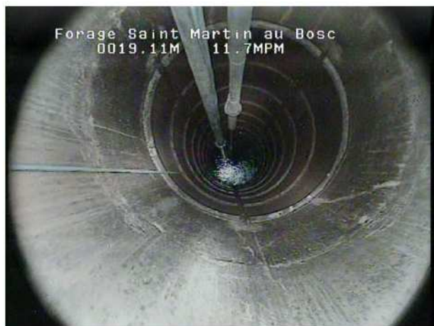
Cuvelage en béton SANS enduit, « brut » avec tambours de 1 m jointifs et réguliers, RAS
