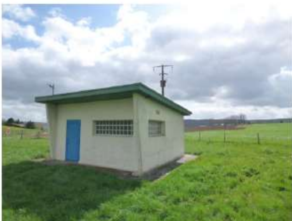
Station de pompage abritant le forage
