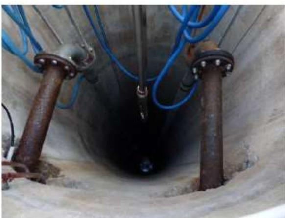
Intérieur du forage
