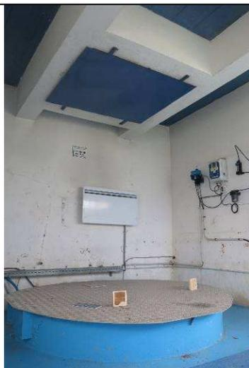
Puits de captage situé dans le bâtiment technique avec margelle et capot de couverture
