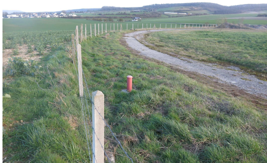
Piézomètre situé en aval de l'ancien dépôt dans l'enceinte clôturée
