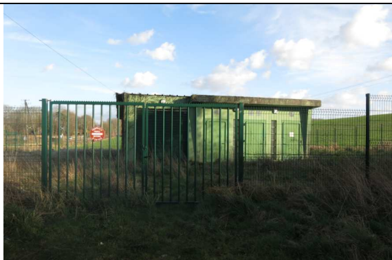
Portail et clôture de protection de 2 m de hauteur autour du captage
