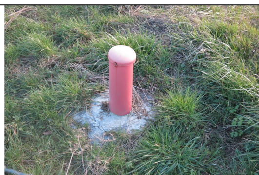
Détail du piézomètre avec tubage acier et capot fermé par cadenas à vis (absence de margelle de protection réglementaire)
