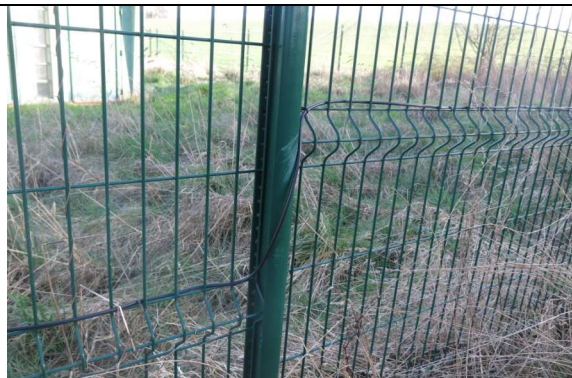
Fil courant en boucle le long de la clôture afin d'assurer une alerte en cas d'effraction
