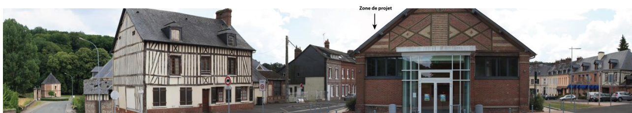
Photographie 25 : Vue depuis le château d'Esneval
