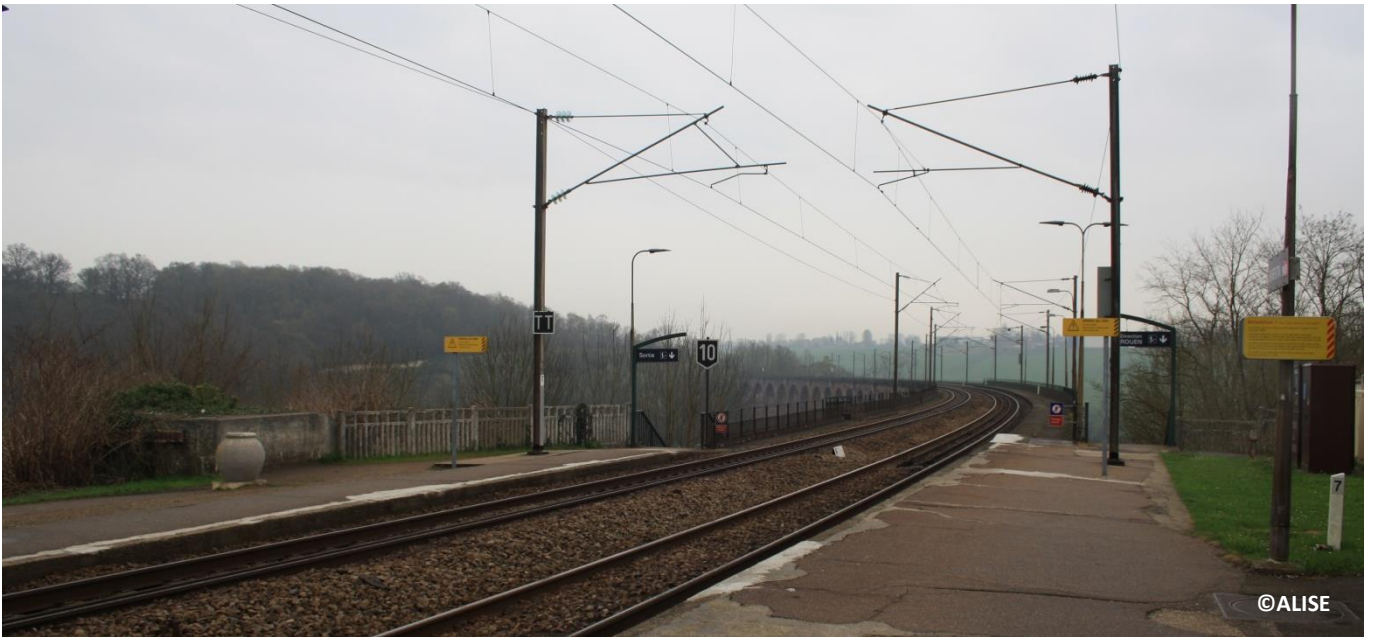
Photographie 8 : Voie ferrée sur la commune de Barentin
