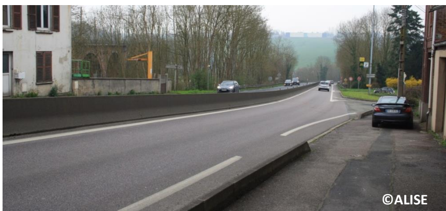
Photographie 24 : Route départementale 6015 à Barentin
