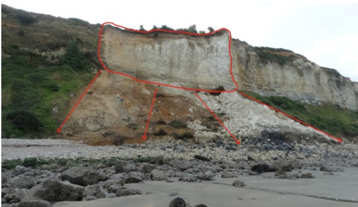
Figure 3: Éboulement entraînant un recul de la crête en limite du Havre et de Sainte Adresse (source ANTEA CODAH juillet 2016)
