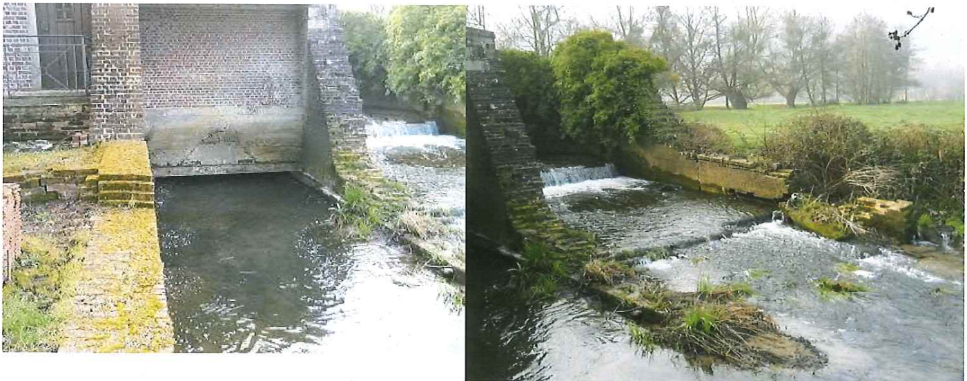
Seuil du moulin (ROE 14282)
