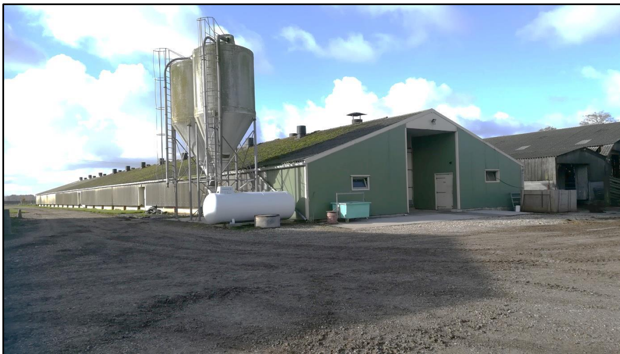
Vue de la façade Sud et du pignon Est du poulailler
