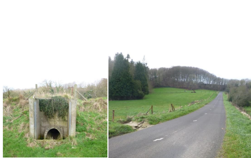
Figure 51 : Photos actuelles avec ouvrage existant
