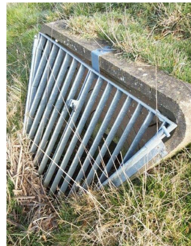
Figure 41 : Exemple de tête de d'aqueduc
