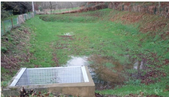
Figure 16 : Ouvrage de fuite existant
