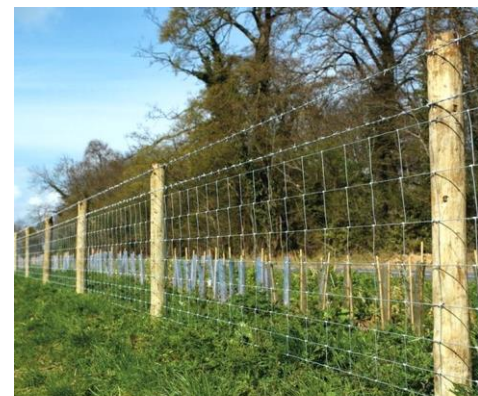
Figure 13 : Exemple de clôture
