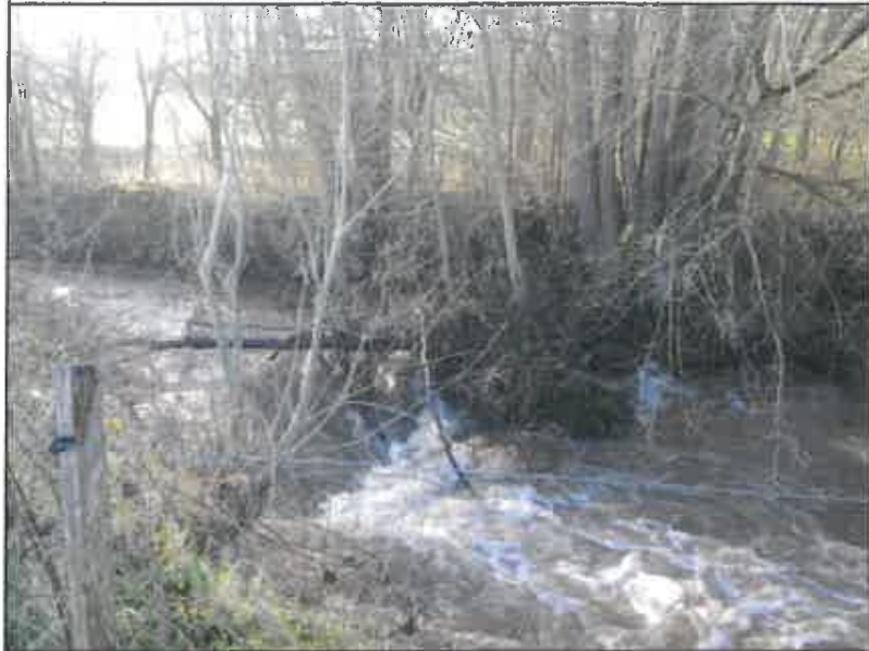
Photo 3 : L'ancien ouvrage d'irrigation (bras droit de la Béthune) et sa chute
