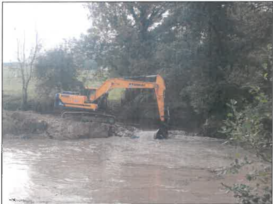
Dérasement du seuil de la chute
