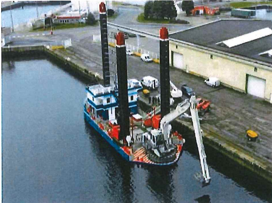
Figure 44 : Exemple de ponton deeper équipé d'une pelle hydraulique de forte capacité - ~120 T, 38 m de lg, 2 m de tirant
