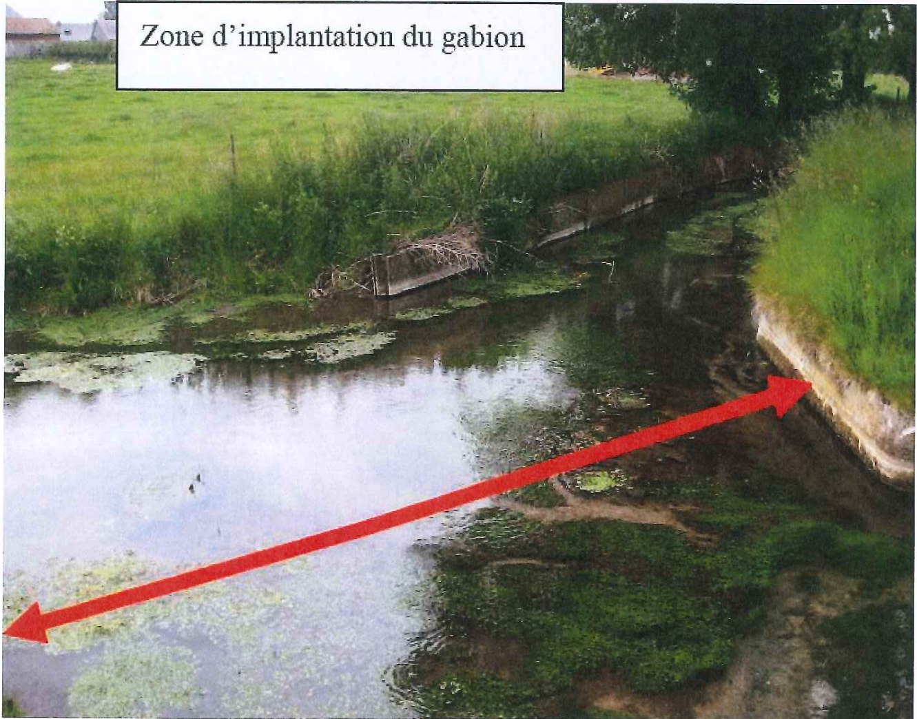
Zone d'implantation du gabion.
