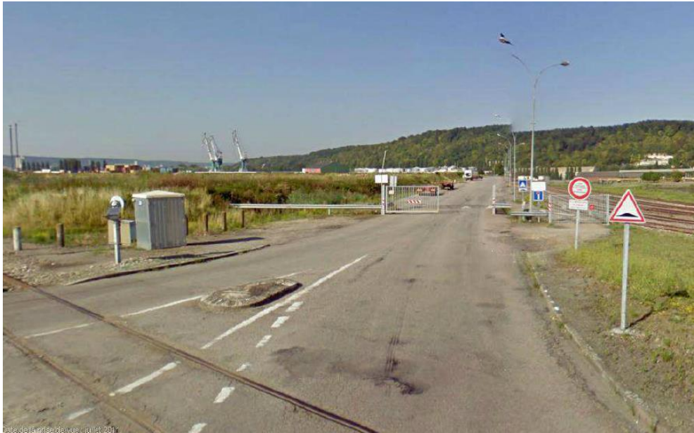
Figure 8 : Accès à la plateforme logistique QPC
