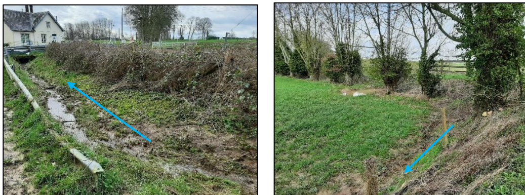
Figure 5 : Terrains en aval de la voie SNCF
