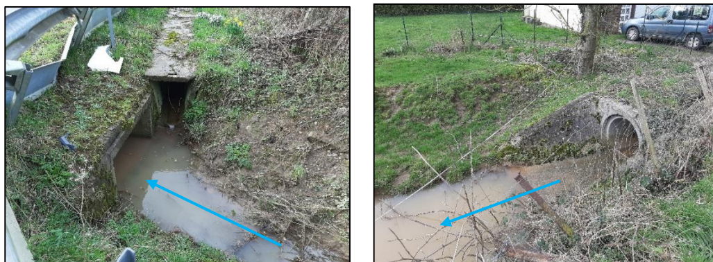
Figure 6 : Entrée et sortie de l'ouvrage sous la RD53.
