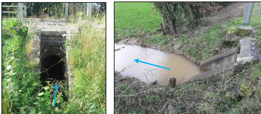
Figure 4 : Ouvrage existant en maçonnerie sous la voie ferrée.
