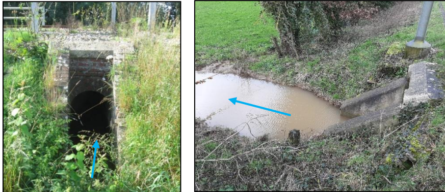
Figure 10 : Ouvrage existant en maçonnerie sous la voie ferrée.
