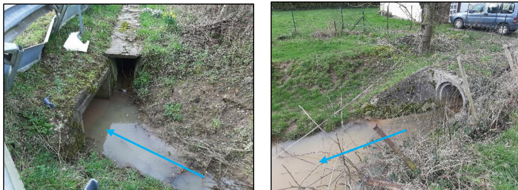
Figure 12 : Entrée et sortie de l'ouvrage sous la RD53.
