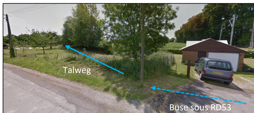
Figure 13 : Exutoire final des aménagements : talweg naturel situé en aval de la maison du « garde barrière ».
