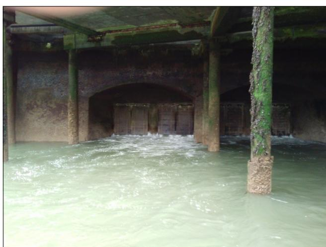
Figure 49: Aperçu des 8 clapets en aval de l'exutoire de l'Arques, dans le bassin du Canada (photographie SMPD)
