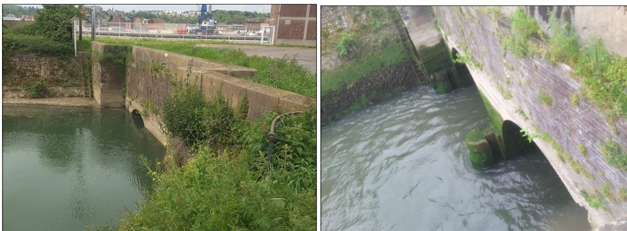
Figure 48: Aperçu des 2 voutes en amont de l'exutoire de l'Arques lors d'une marée de coefficient 60 (30 min après la pleine-mer à gauche, 2h30 après la pleine mer à droite) (photographies BRGM)
