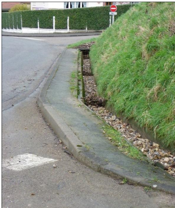
Figure 117: Obstruction du réseau pluvial le long de l'avenue Alexandre Dumas à Puys (05/02/2013)
