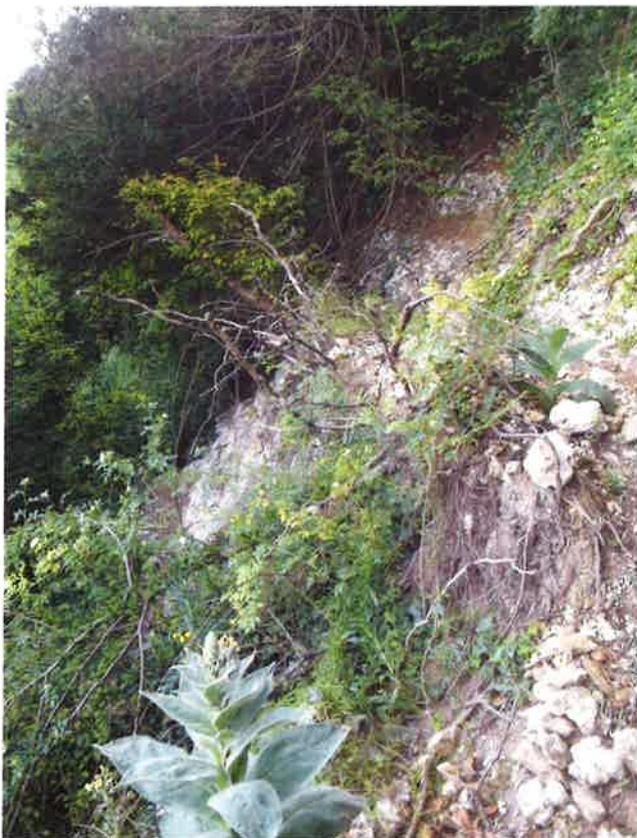
Instabilité de pierres et petits blocs dans le talus crayeux raide en amont du n°75, provoquée par le déracinement d'un arbre
