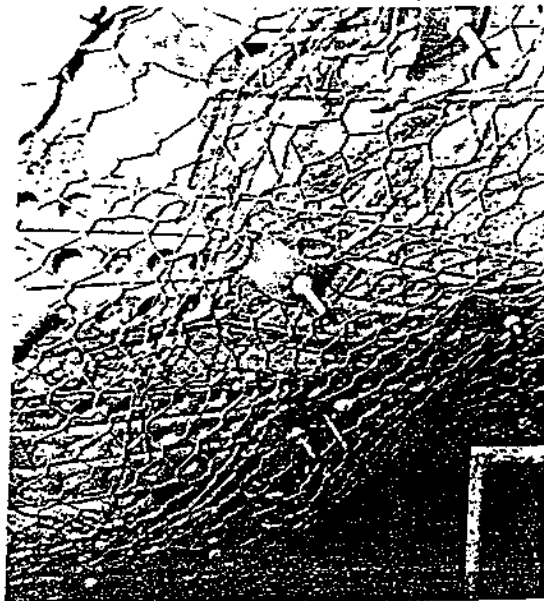
Boulons, plaques et grillage
